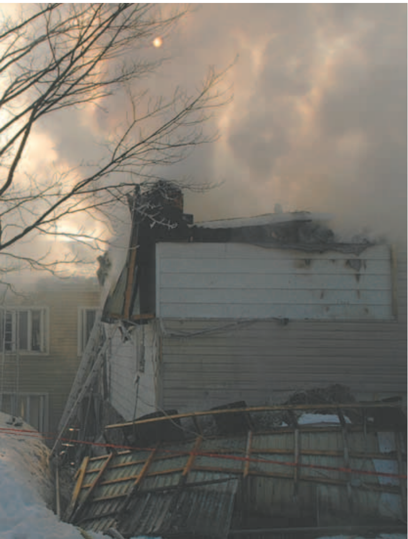
C'est la nouvelle partie du Manoir L'Émeraude qui a été anéantie par l'incendie. La paroi coupe-feu a protégé l'ancienne partie dans laquelle se trouvaient les résidents.
