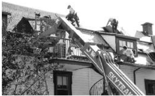
Travaux de réfection sur le toit de la gare
