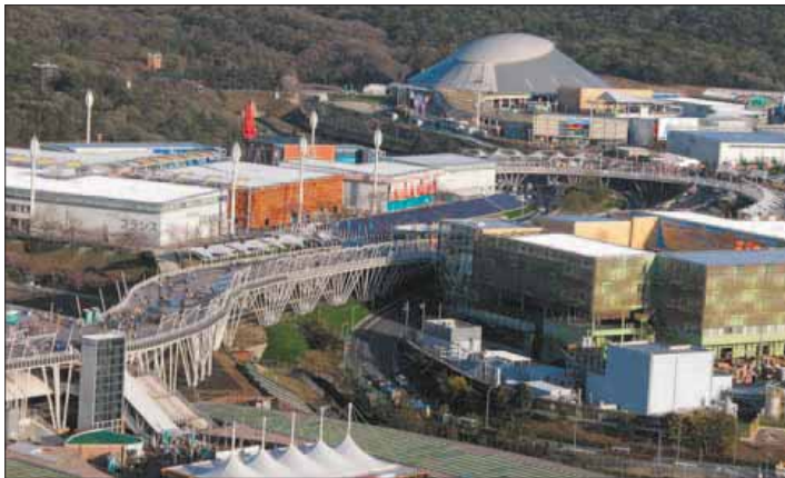
Vue aérienne d'une partie seulement du site de l'Exposition universelle d'Aichi au Japon.
